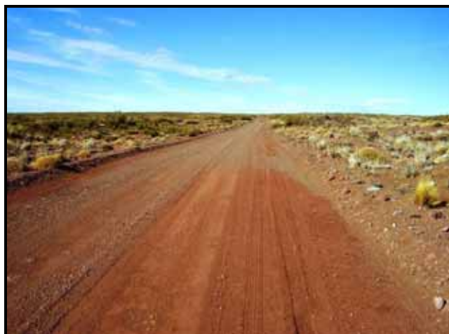
Foto III.1: Vista al Sur de la Ruta Provincial Nº 1. Coordenadas Y: 2.457.658; X: 5.767.538
